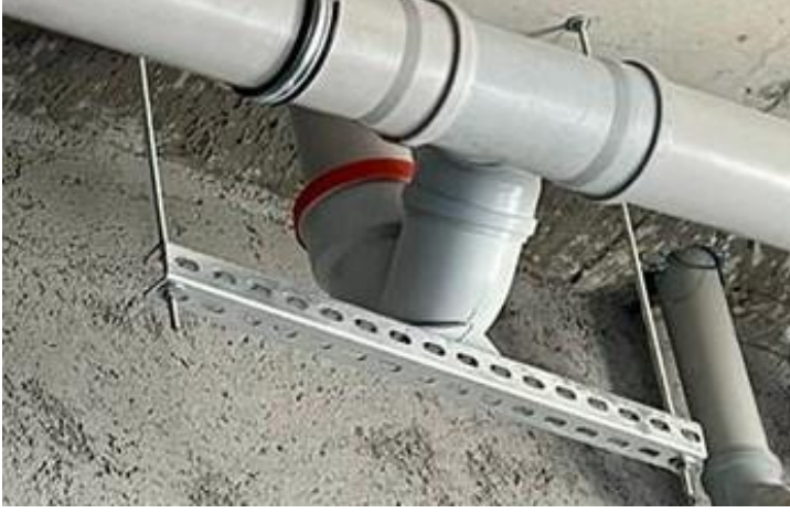
Resim 28. S Borularının Bağlantı İmalatına İlişkin Örnekler
