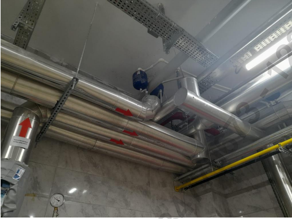
Resim 77. Kalorifer Hattı Sac Kaplama Örneği
