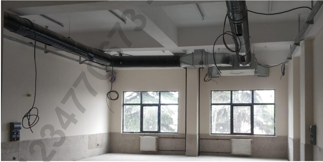
Resim 57. Isı Geri Kazanım Cihazı Kanal Bağlantıları İmalat Örneği
