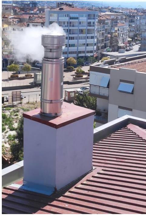
Resim 45. Doğal Gaz Hattı Ve Bacası İmalat Örnekleri
