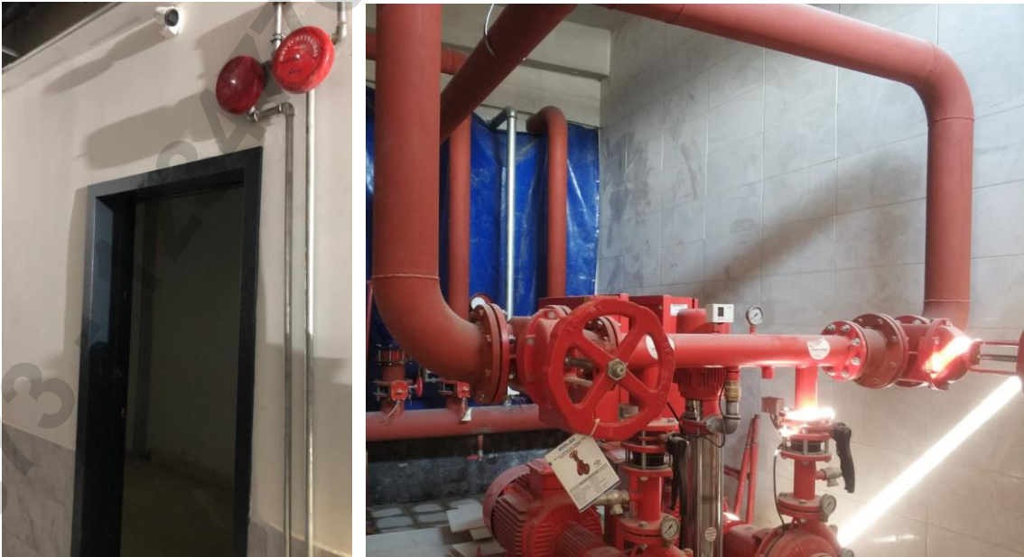
Resim 47. Yangın Gongu Ve Yangın Pompası Örneği
