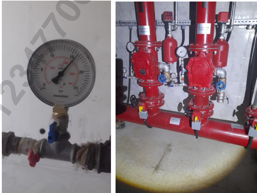
Resim 49. Yangın Hattı Basınç Testi Örneği
