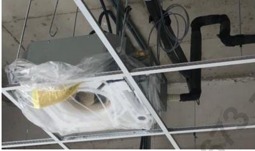
Resim 87. Drenaj Bağlantısı Ve Ters Sifonlama İmalatı Örneği
