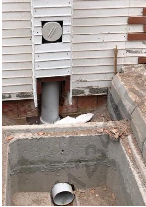
Resim 12. Çatı Yağmur Suyu Hattı Ve Temizleme Kapağı Montajı Örneği
