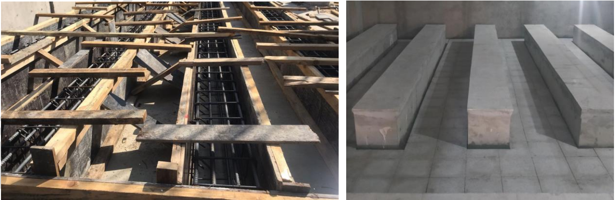
Resim 25. Su Deposu Kaide İmalatı Örneği
