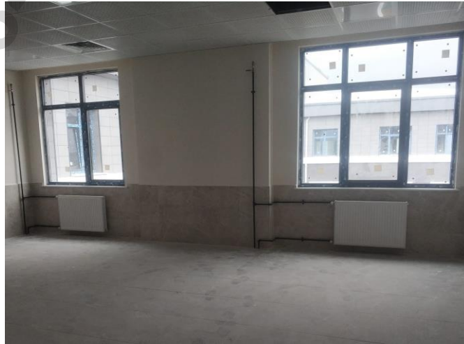
Resim 74. Kalorifer Purjör Bağlantı Örneği
