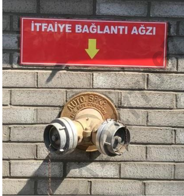
Resim 48. İtfaiye Bağlantı Ağzı Levhası Montaj Örneği
