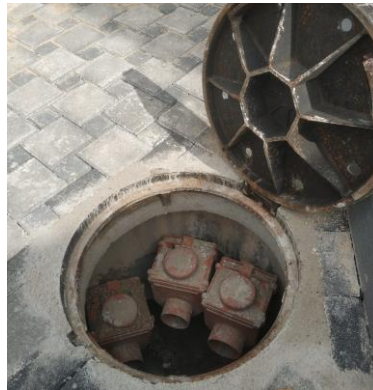
Resim 15. Pis Su Çek Valflerinin Bağlantı Örneği
