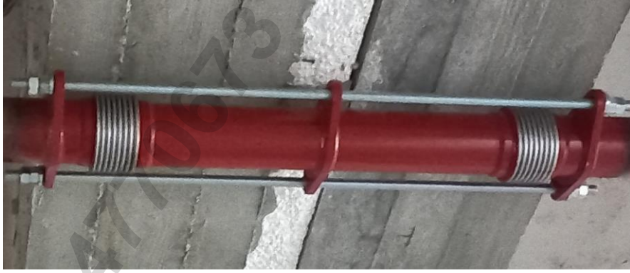
Resim 19. Dilatasyon Geçişinde Yangın Hattı Kompensatör Bağlantı Örneği
