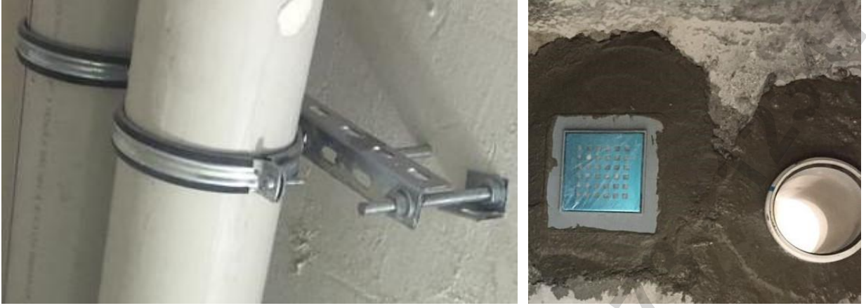
Resim 37. Pvc Boru Ve Süzgeç İmalatlarına İlişkin Örnekler
