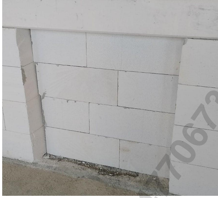
Resim 5. Kalorifer Kollektör Dolabı Gaz Beton Lento Uygulaması Örneği
