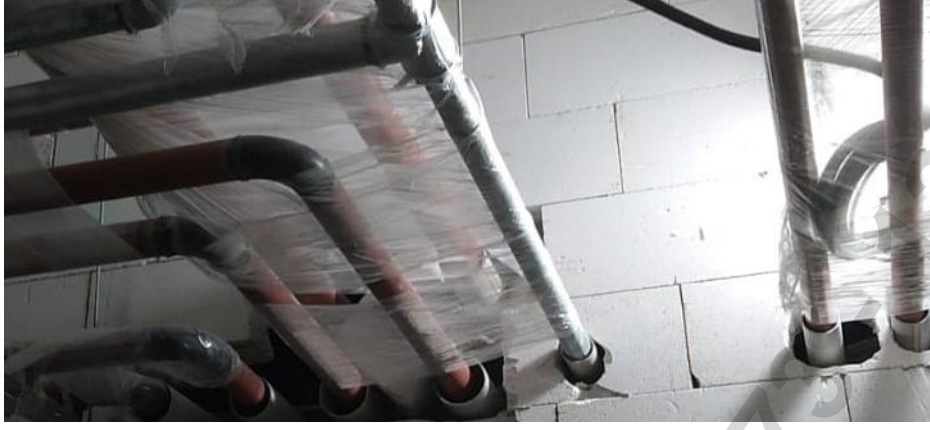
Resim 10. Duvar Geçişlerine Pvc Konulması
