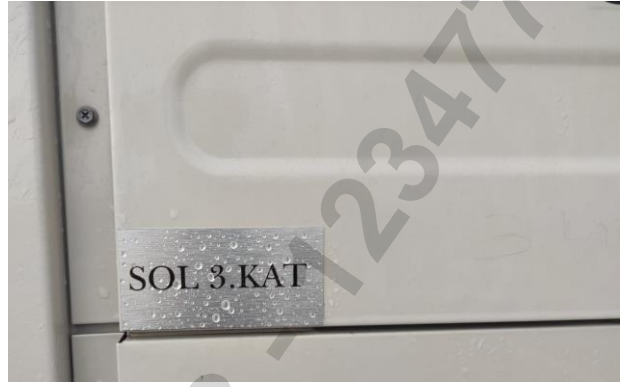
Resim 81. Vrf Dış Ünite Üzerinde Etiketleme Örneği
