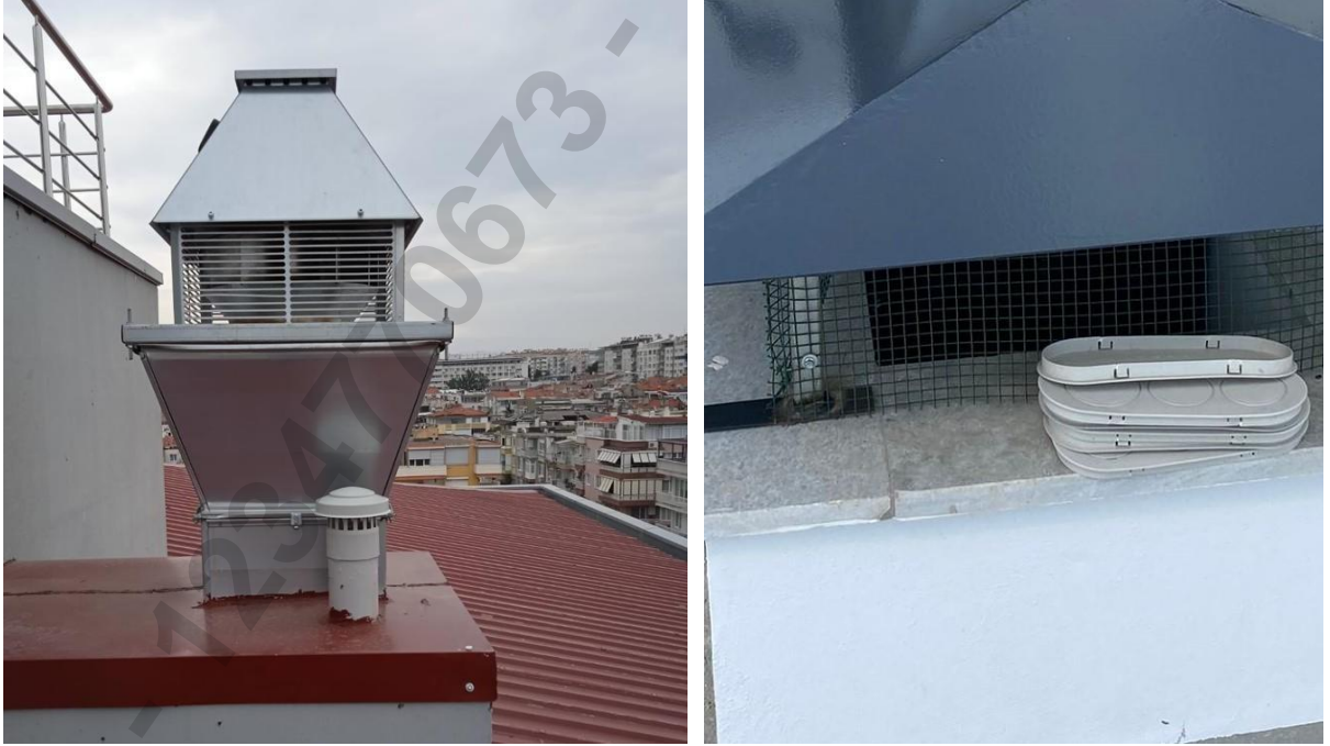
Resim 63. Çatı Tipi Aspiratör Ve Havalık İmalat Örnekleri
