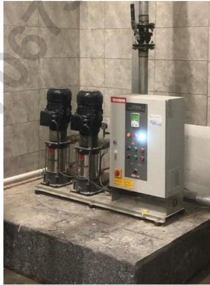
Resim 39. Temiz Su Hidroforu Bağlantı Örneği
