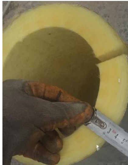
Resim 76. Isıtma Hatları Prefabrik Cam Yünü Kalınlık Ölçümü
