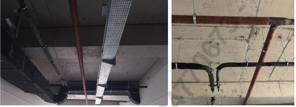
Resim 83. Vrf Bakır Borulama İmalatı Örnekleri
