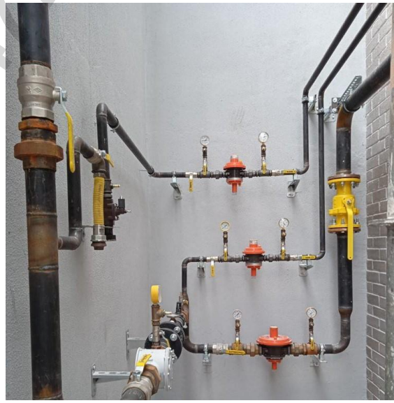
Resim 44. Doğal Gaz Hattı İmalat Örneği
