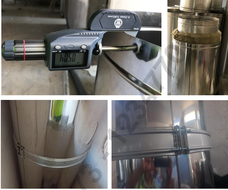
Resim 43. Doğal Gazlı Kalerifer Bacası Dış Sac Kalınlık Ölçümü, Cidar Testi Ve Baca Bağlantı Örnekleri
