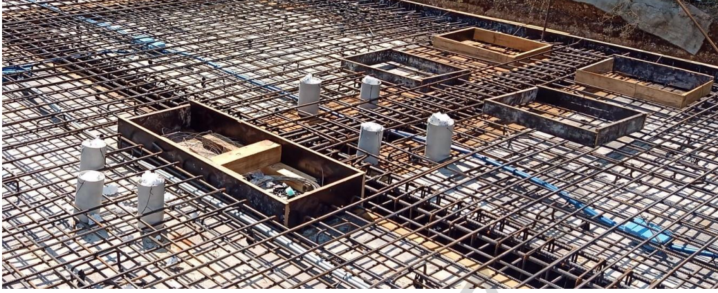
Resim 16. İmalat Aşaması Mekanik Rezervuarlara Ait Örnek
