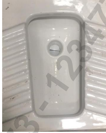
Resim 29. Alaturka Tuvalet Yaylı Delik Kapağı Takılması
