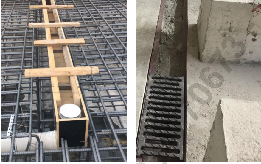
Resim 18. Izgara Uygulaması İmalat Örneği
