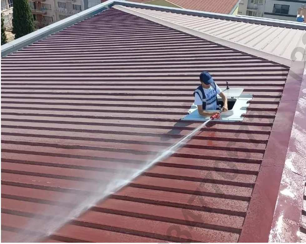
Resim 50. Yangın Dolabı Ve Yangın Hattı Testlerine Ait Örnek
