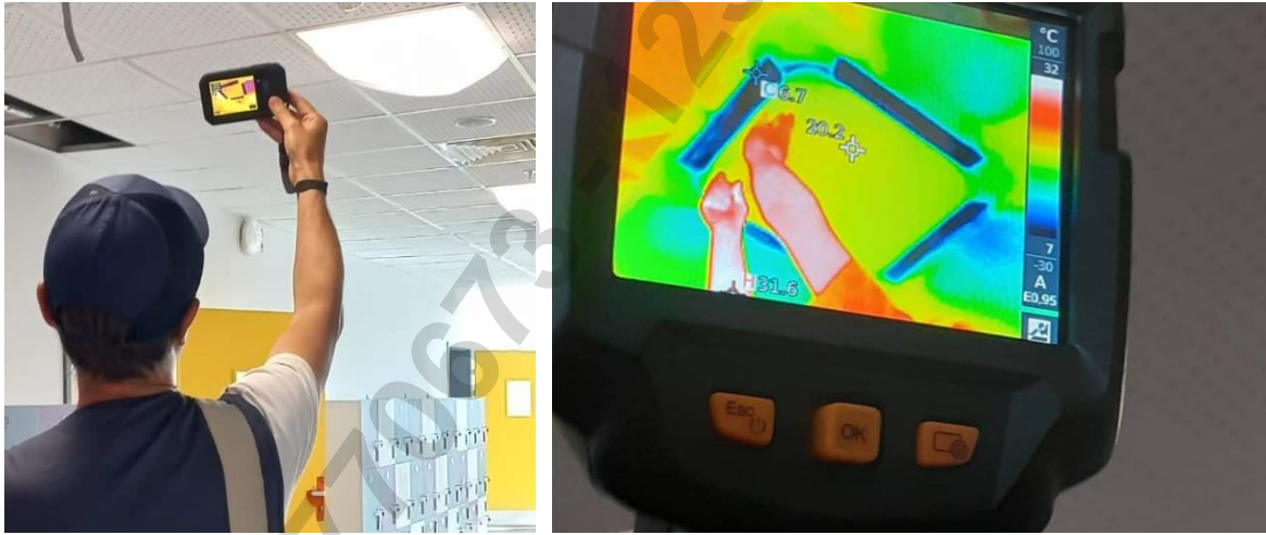
Resim 88. Vrf Soğutma Ölçümü Ve Testi
