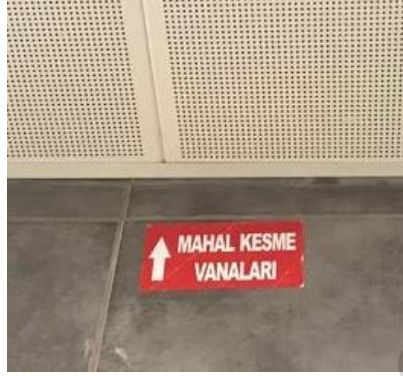
Resim 21. Kesme Vanası Etiketleme Örneği
