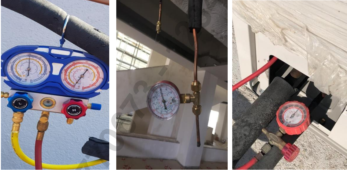
Resim 86. Vrf Basınç Testlerine İlişkin Örnekler
