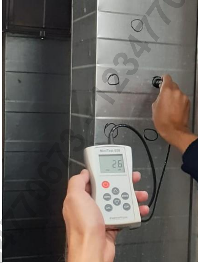
Resim 54. Havalandırma Kanalı Galvaniz Kalınlığı Ölçüm Örneği
