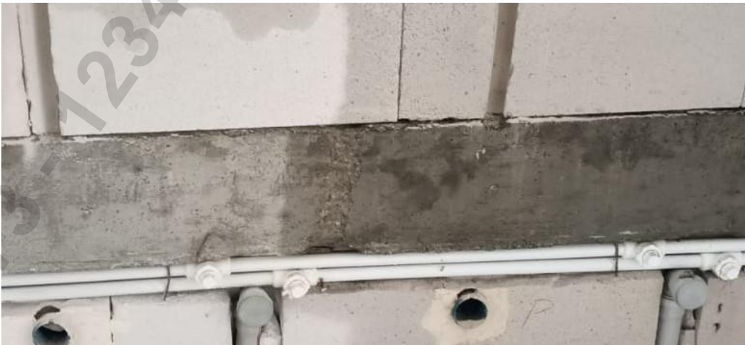
Resim 4. Lavabo Profilleri Montaj İmalatı İçin Beton Lento Uygulaması Örneği
