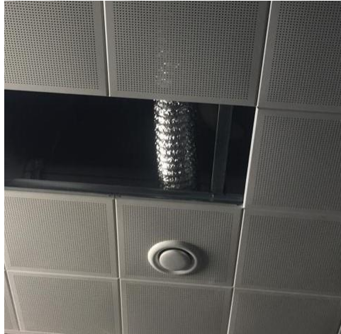
Resim 33. Islak Hacim Anemostat Bağlantı Örneği
