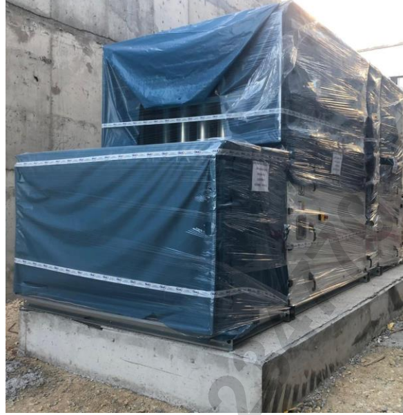
Resim 59. Klima Santralinin Şantiye Alanında Muhafaza Edilmesi
