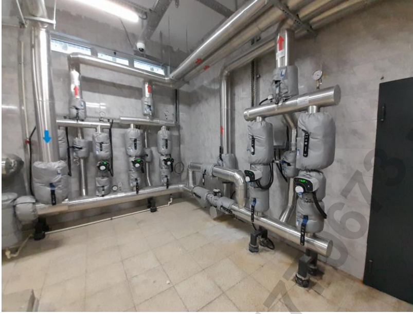
Resim 73. Kalorifer Kollektör Hattı Yalıtım Ceketi İmalat Örneği
