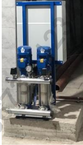
Resim 9. Beton Kaide Yüksekliği
